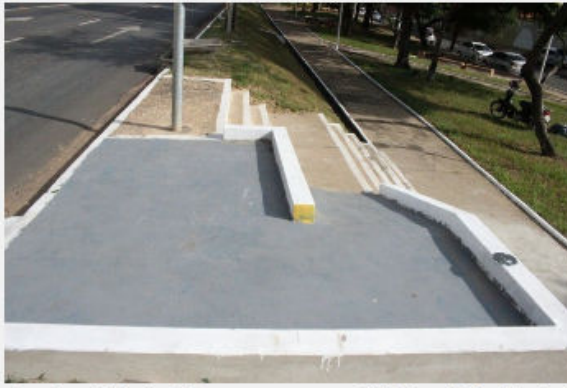
Rampa inadequada a deficientes físicos e pessoas com mobilidade reduzida. Foto: José Marcelo/G1
