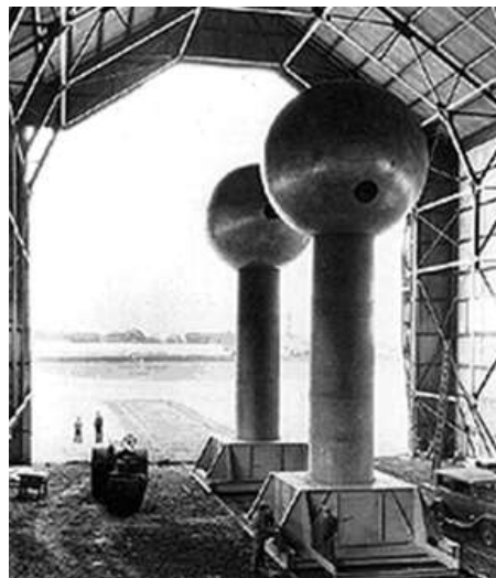
Figura 2.2 – GVG construído por Robert Jemison Van de Graaff. Fonte: http://www.geocities.ws/saladefisica9/biografias/vandegraaff.html
